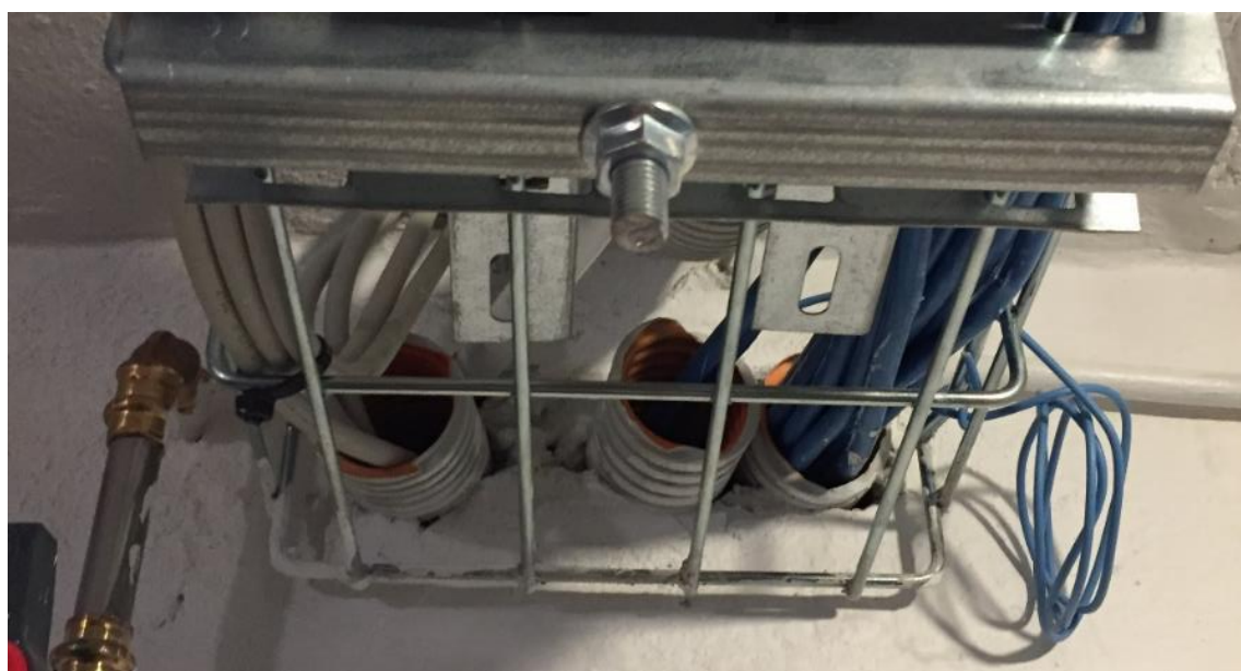
Figur 2: Manglende brandtætning ved installationsgennemføring i kælder
